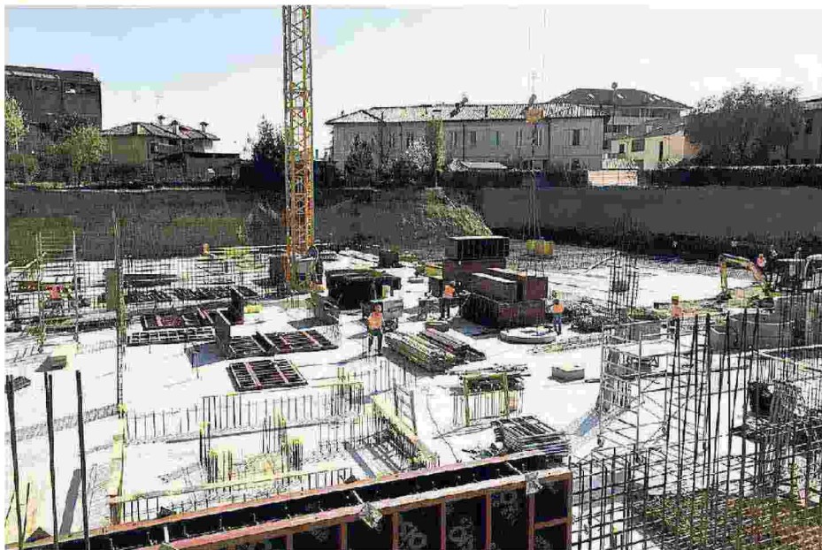
Un'immagine del cantiere per la costruzione di 56 alloggi in via Lumignacco, vicino a piazzale Cella
